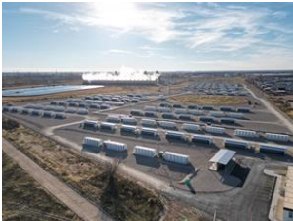
Odessa Data Center Area C
